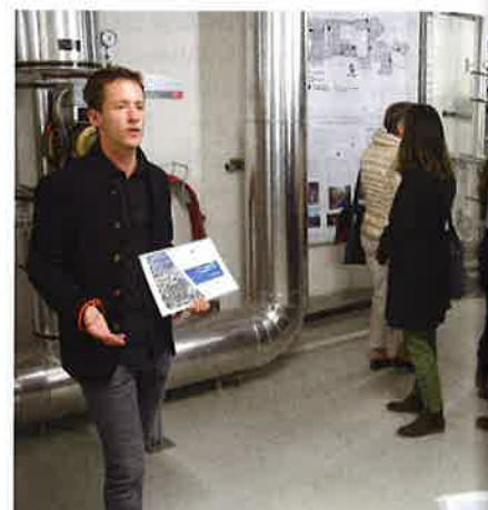
Matthias Kolb, Amstein + Walthert AG, hat in der Energiezentrale das Konzept des Niedertemperaturnetzes vorgestellt.
