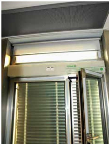
Beim Oberlicht dienen einfache Storen als Sonnenschutz. Darüber befindet sich eine Akustikplatte.
