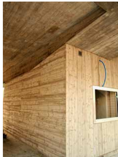
Architektursprache: Der neue Beton (unten) verbindet sich mit dem alten von 1963.
