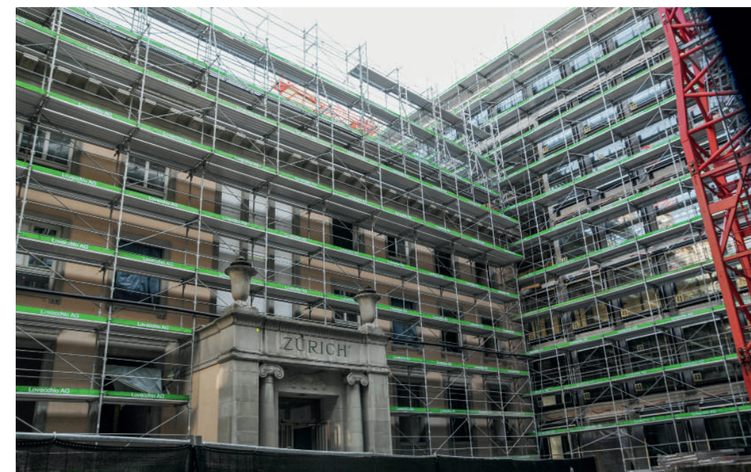
Alt neben neu: Im zentralen Verwaltungsgebäude, dessen ionische Säulen an einen Tempel erinnern, befanden sich die ersten Grossraumbüros der Stadt.
