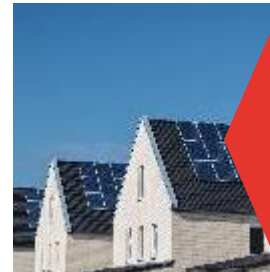
Sonnenkollektoren und Photovoltaik
