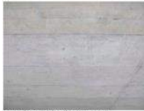
Decke, Sichtbeton Typ II, mit pigmentierter Lasur
