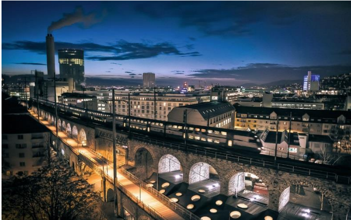
Ausbau Fernwärme aus KVA
